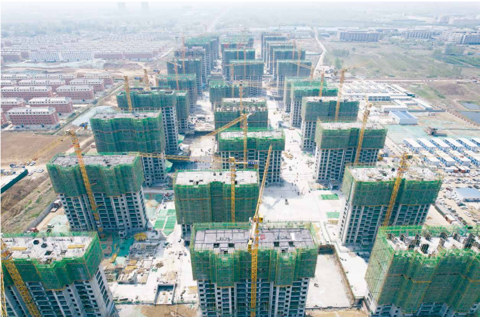
山东临沂项目安置房建设现场图
